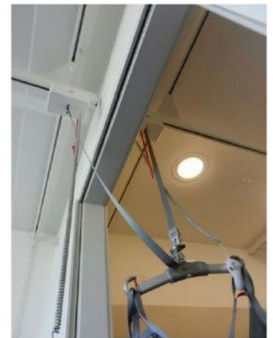
Deckenliftsystem mit Umhängemöglichkeit des Lifertuches am Türsturz
